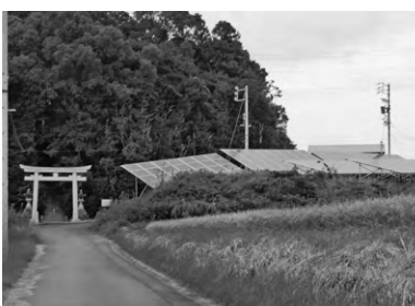
太陽光発電設備
