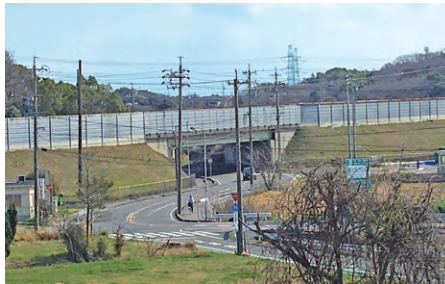
都市計画道路名古屋半田線(東浦町地区から)
