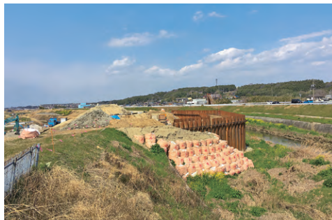
植大工区 新排水機場の建設
