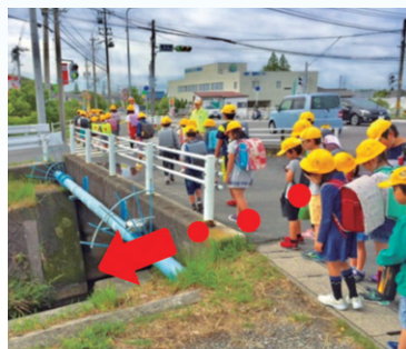
ガードパイプ無し！
