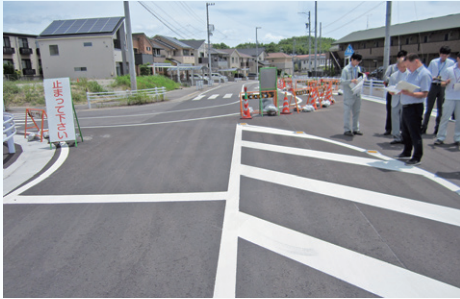
▲矢高横川線宮津地内
