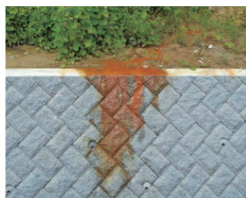
斜面から鉄分を含む漏水が確認できる
