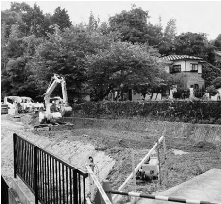
工事が進む町道4035号線 (大字卯坂地内)
