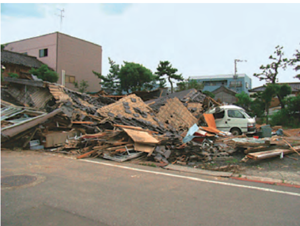
震度6強の地震で倒壊した新潟県柏崎市の家屋
