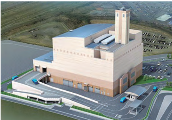
平成31年3月完成予定 新クリーンセンター
