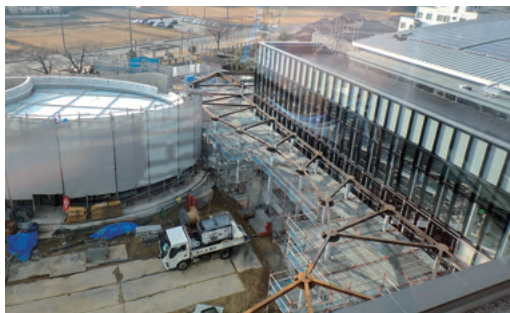
建設中の多目的ホールと食堂棟
