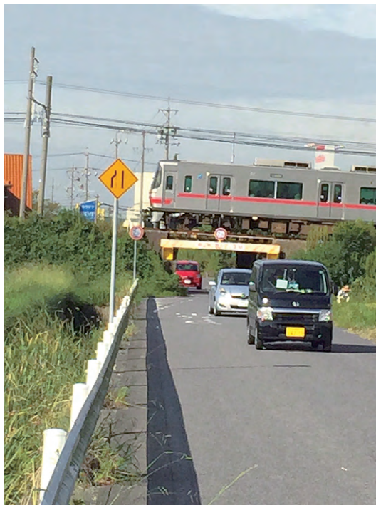
課題となっている名鉄河和線との交差点箇所
