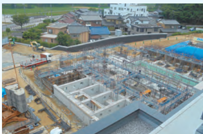
多目的ホール基礎工事 (H28.6.9)
