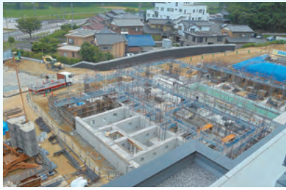
多目的ホール基礎工事 (H28.6.9)
