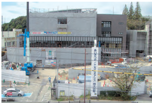
工事中の新庁舎（9月30日現在）
