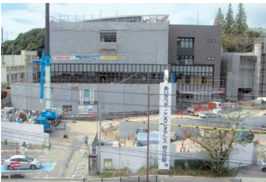
工事中的新庁舎（9月30日現在）
