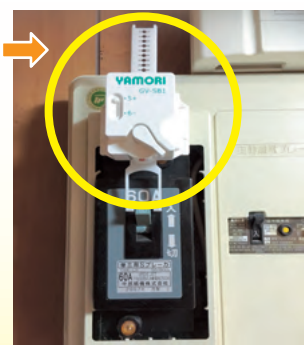
「感震ブレーカー」地震の揺れを感知して自動的に電気を遮断する装置
