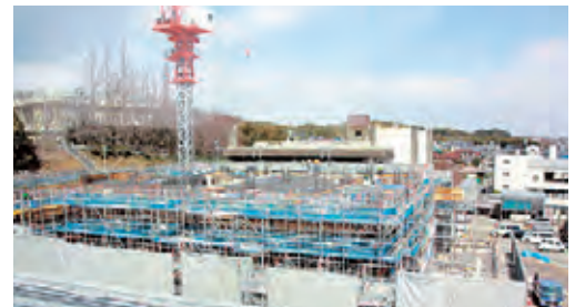
新庁舎建設工事中 (H27.3.22) 年内完成予定
