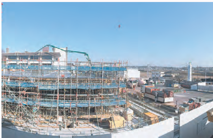
新庁舎建設風景
