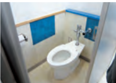
海老名市立大谷小学校のトイレ 多目的トイレ(上) 一般トイレ(下)
