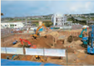
新庁舎基礎工事
