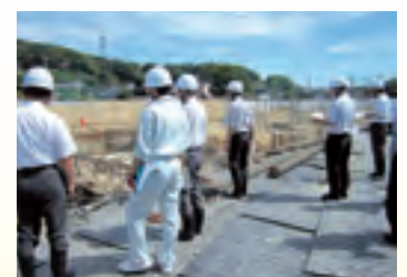
東部小校舎増築工事現場
