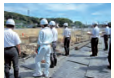
東部小校舎増築工事現場
