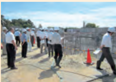
阿中プール新築現場
